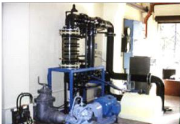
Trinkwasserversorgung für ca. 3.000 Einwohner Entkeimung Wasserzulauf / Hebetank
