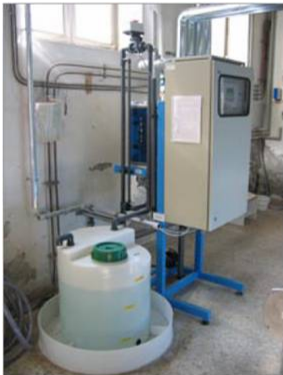
RPZ2/160HT-KW mit Spülflüssigkeitstank
